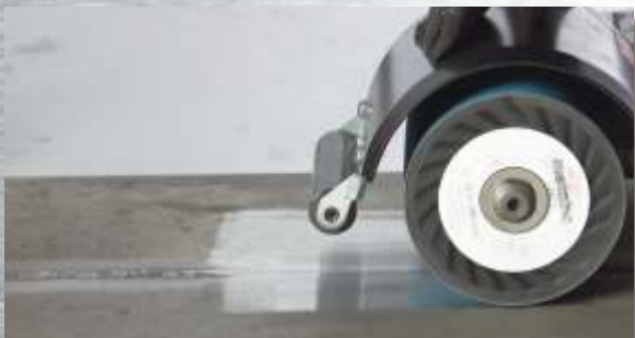
Zgrubne usuwanie materiału: za pomocą wałka rozprężnego uzbrojonego w pasy bezkońcowe o ziarnistości P60, P80 lub P120.
