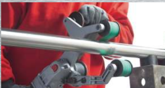
Szlifowanie spoin spawalniczych szlifierką taśmową do rur, wyposażoną w taśmę szlifierską z nasypem ceramicznym (P80) gwarantuje bardzo dużą wydajność pracy przy długiej żywotności pasa ściernego.
